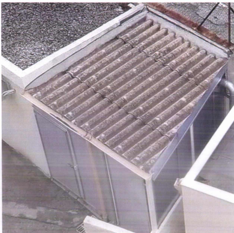
Atelier 2 (Enveloppe extérieure) - Toit - Plaques ondulées fibrociment
